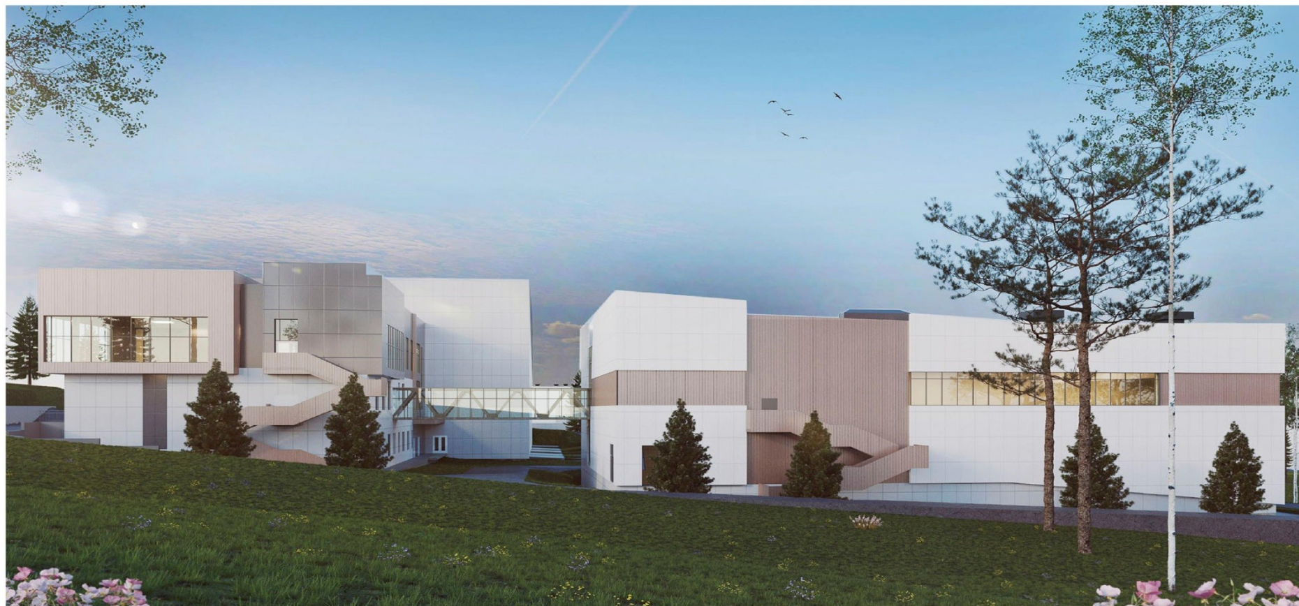
Вид с Юго-Восточной стороны
